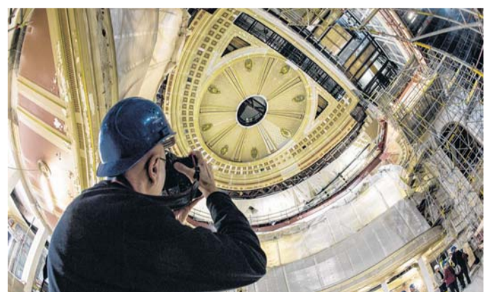
Die restaurierte Saaldecke der Berliner Staatsoper ist bereits fertig. Viele andere Stellen aber nicht.
